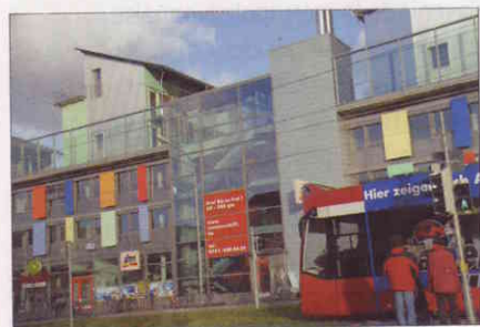
Le centre commercial à toitures PV.
