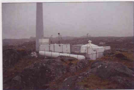
Au pied de l'une des deux éoliennes de l'île, la station de fabrication, de stockage et de combustion de l'hydrogène.
